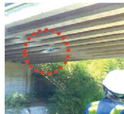
ドローンによる 橋梁点検の様子
