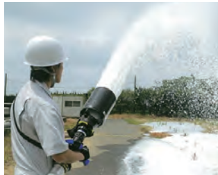
環境配慮型消火液剤散布の様子
