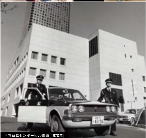
世界貿易センタービル警備[1970年]
